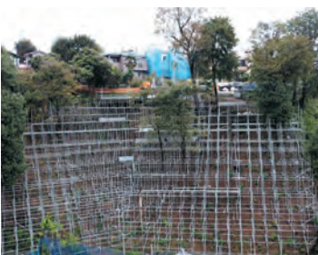
工事の一例④（緑地法面保護工事）
