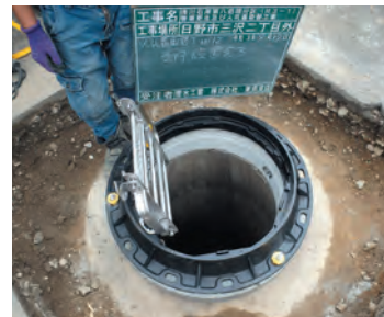
工事の一例② （管渠更生及び人孔蓋取替工事）
