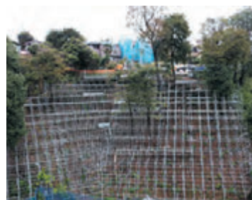
工事の一例④（緑地法面保護工事）
