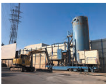
汚泥処理プラント
